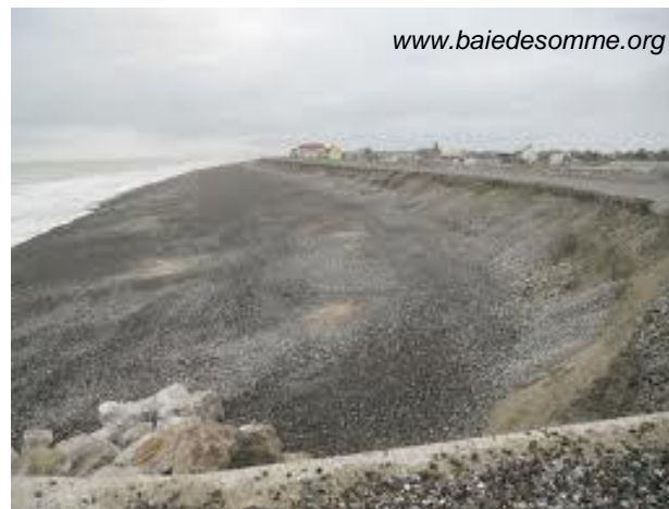
Érosion sur la côte picarde
